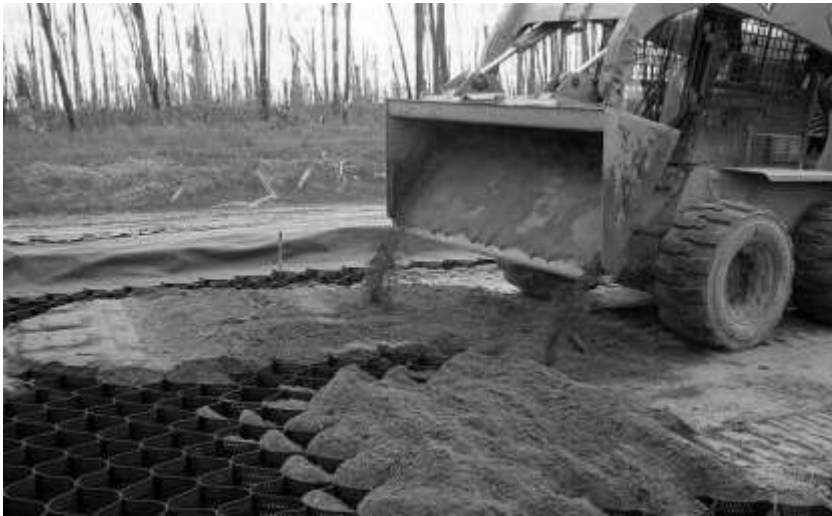
شکل ۱-۱ الف و ب: استفاده از تسلیح سه بعدی در راهسازی
