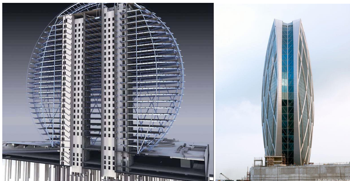
شکل (۲-۱۰ و ۲-۱۱) ساختمان آلدار ابوظبی ماخذ: www.arcline.ir
