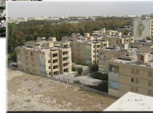
مجموعه های مسکونی (شرق سایت)
