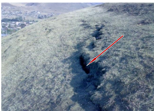
شکل ۴. ترکهای ایجاد شده در اثر زمین لغزش
