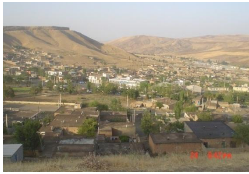
شکل ۶. قرارگیری ساختمانهای مسکونی در شیبهای تند
